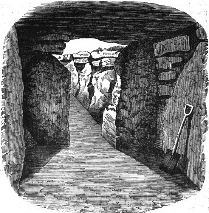
La salle vue de l'entrée.
